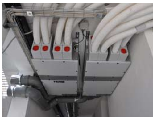
I due apparecchi HomeVent® 180 alloggiati.
