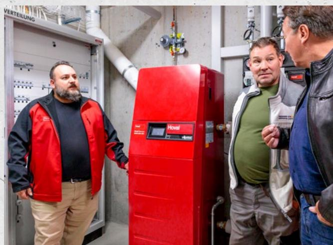
Ein Gasbrennwertkessel UltraGas® 50 in Kombination mit einem Wassererwärmer ESSR 1000 beheizt die 1 500 m<sup>2</sup> Wohnfläche.
