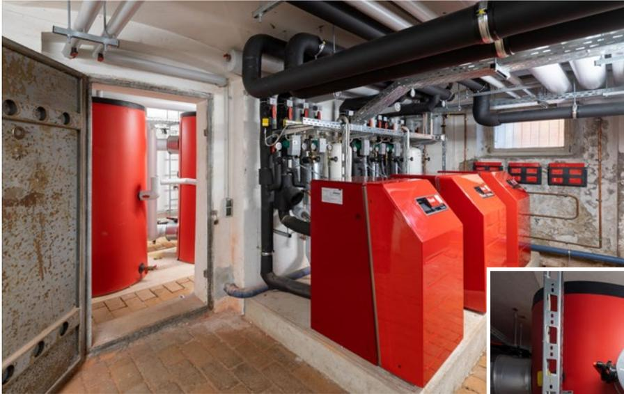
Die neue Heizzentrale besteht aus einem Gasbrennwertkessel UltraGas®, drei Wärmepumpen Thermalia® und einem Blockheizkraftwerk (BHKW).
